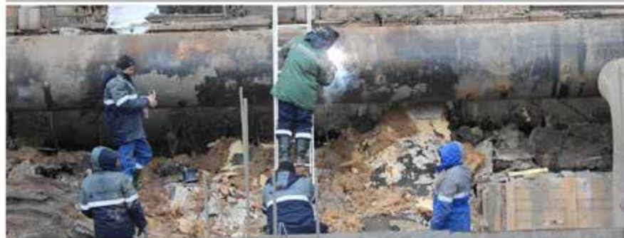
Une équipe des infrastructures de Kyïv en train de réparer une conduite d'eau endommagée par une attaque de drone ou de missile russe
